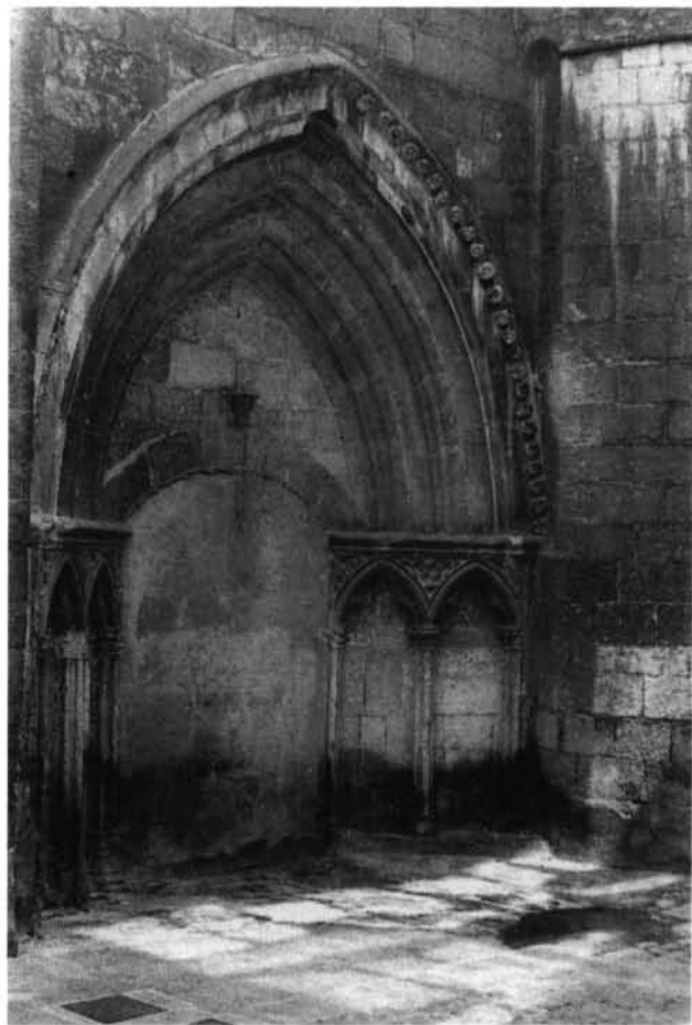
FIG. 1. Vista general del portal norte de San Pedro de Vitoria.
