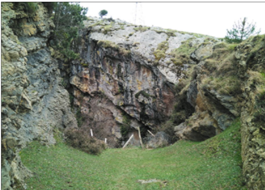
Vista del acceso al mirador situado sobre socavón minero.
