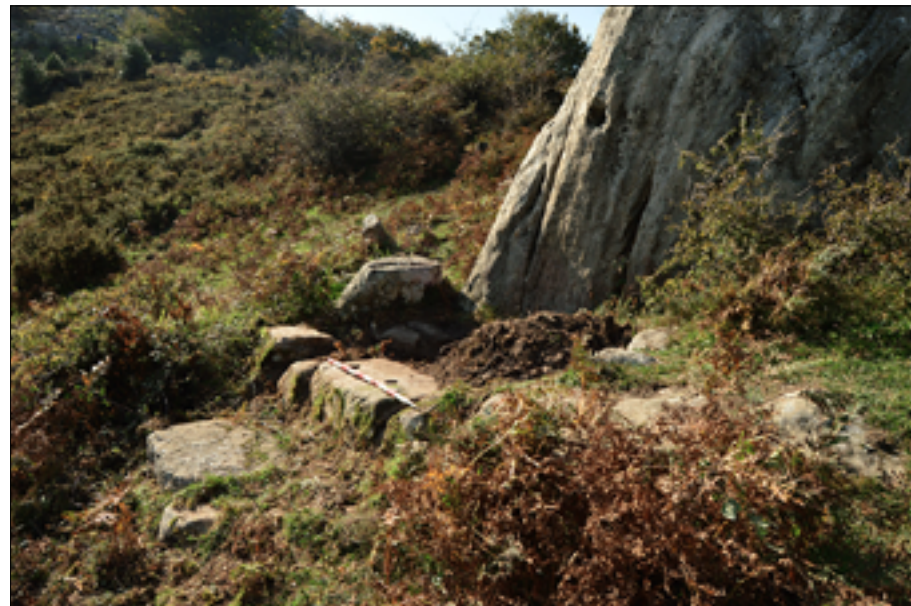
En Apoeta, restos de una edificación rudimentaria construida aprovechando la roca arenisca como apoyo de sus elementos estructurales y el cobijo de animales o personas.
