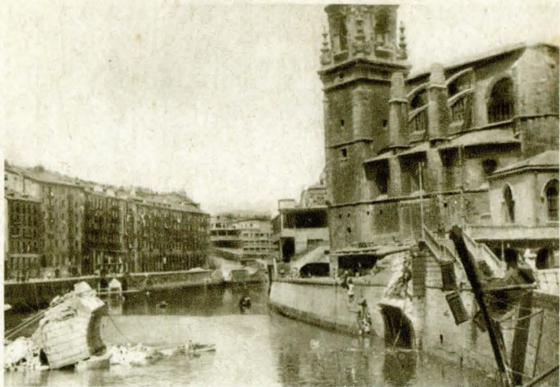
El puente de San Antón destruido.
