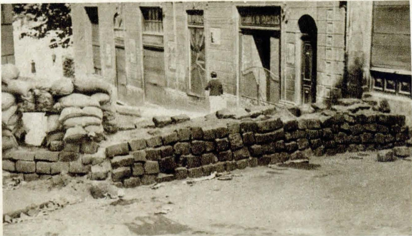
Trincheras en las calles de Bailén y Hernani.
