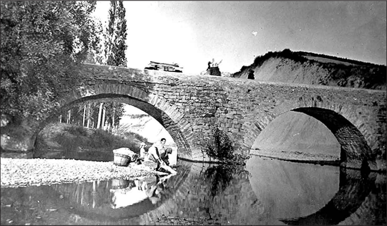
Lavanderas junto al puente viejo de Burlada.
