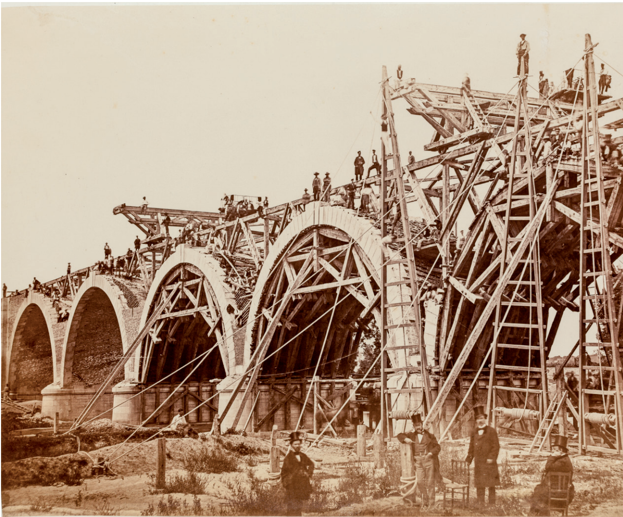
Construcción del Puente de los Franceses en Madrid, hacia 1860. Foto: C. Clifford. Fototeca IPCE
