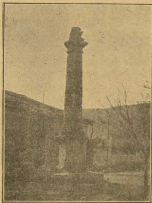
Rollo de Alhóndiga.
