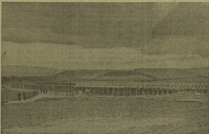
Acueducto de 42 arcos que salva una depresión de terreno entre las provincias de Logroño y Alava, construido en el canal primero del Regadío de Oyón (Foto Parra).
